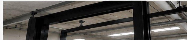
Aisle Door Frames
